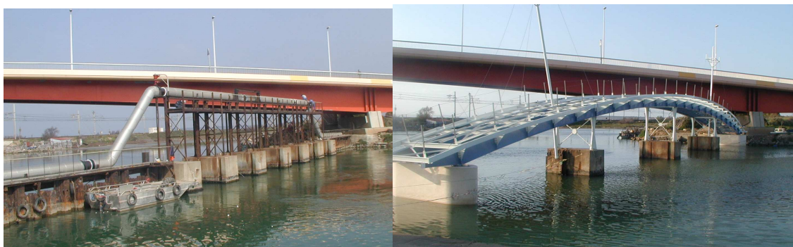
Enlèvement du barrage à vannes en 2004 : la section dans le grau est passée de 54m 2 à 102m 2 à cet endroit
