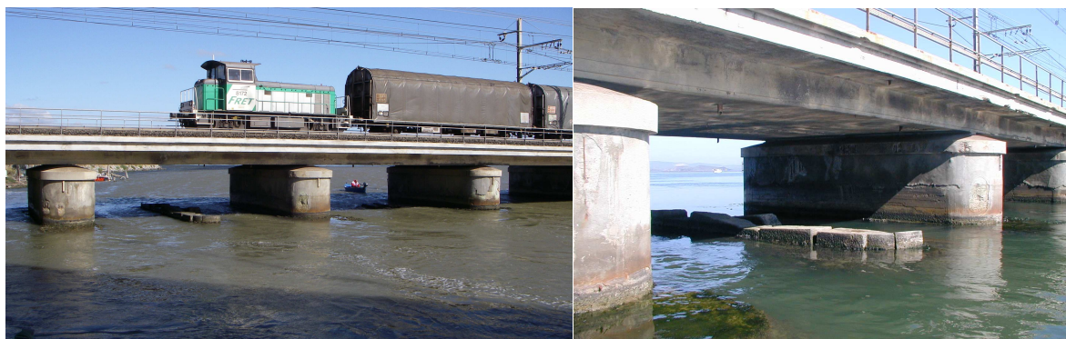
Pont de la voie ferrée : les anciennes piles en pierres réduisent la section d'échange à 59 m 2 au débouché du grau dans l'étang. Leur enlèvement permettrait de retrouver une section de 100m 2 , équivalente à celle qui existe aujourd'hui au niveau de l'ancien barrage à vannes.
