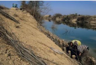
> **Stabilisation des berges** - L'effondrement des berges abruptes est un problème fréquent le long des canaux. Le reprofilage des berges en pente douce (<45°) et la végétalisation (enherbement, plantation localisée d'arbustes...) sont à rechercher.
