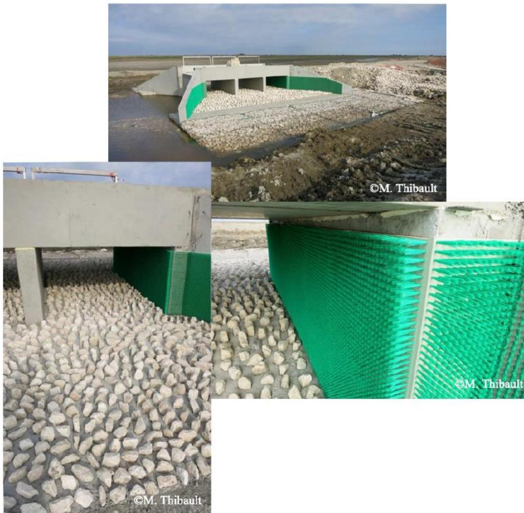
Figure A2-54 : Photographies du nouvel ouvrage de connexion entre l'étang du Galabert et l'étang du Tampan prises le 9/9/2019. Des pierres ont été incrustées dans le radier pour faciliter le passage des poissons et un tapis-brosse a été installé sur les parois pour faciliter les franchissements des civelles.
