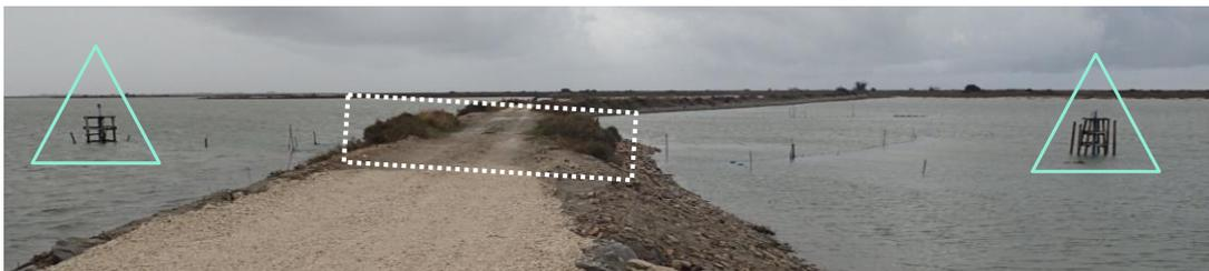
Figure 19 : Photographie représentant la position des sondes de mesures de part et d'autre de l'ouvrage de connexion Galabert/Tampan, ici symbolisé par le rectangle en pointillés. Les sondes sont disposées à l'intérieur de tubes PVC solidement amarrés à des structures en bois. 21/10/2019 © DNS
