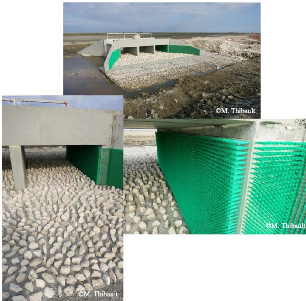
Figure A3-64 : Photographies du nouvel ouvrage de connexion entre l'étang du Galabert et l'étang du Tampan prises le 9/9/2019. Des pierres ont été incrustées dans le radier pour faciliter le passage des poissons et un tapis-brosse a été installé sur les parois pour faciliter les franchissements des civelles.
