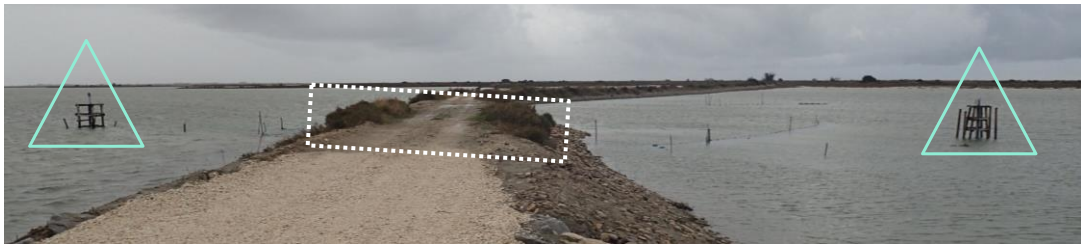
Figure 4 : Photographie représentant la position des sondes de mesures de part et d'autre de l'ouvrage de connexion Galabert/Tampan, ici symbolisé par le rectangle en pointillés. Les sondes sont disposées à l'intérieur de tubes PVC solidement amarrés à des structures en bois. 21/10/2019 © DNS
