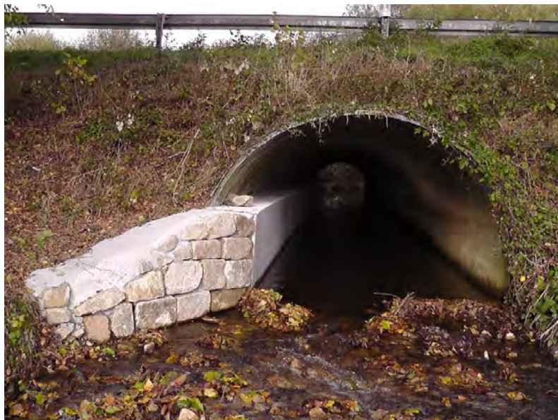
Figure 11a : Aménagement d'un passage à Loutre par la DIR Ouest dans le Morbihan (F. Simonnet).
