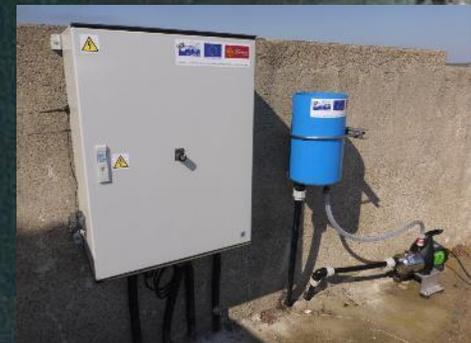
Armoire de mesure et dispositif de pompage
