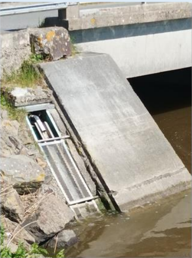
Aménagement de continuité écologique – Barrage des Vallées
