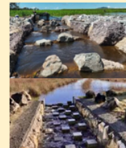
Photos 71 et 72 : Illustrations rampes en enrochement (@Catchment solutions - FDAAPPMA 33).
