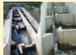
Photos 69 et 70 : Illustrations passe à poissons à fente verticale (@ECOGEA).
