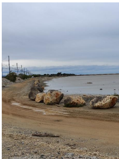
Illustration 46. Berge naturelle du Lido Nord Rouet. Les rochers n'empêchent en aucun cas à l'eau de circuler. Ils sont là pour éviter la circulation des voitures sur le lido
